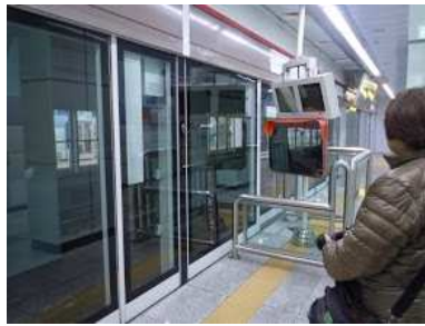
大邱地下鉄の火災事故現場訪問。駅員はおらず、運転手が見えるようにミラーが付けられているのみ。
